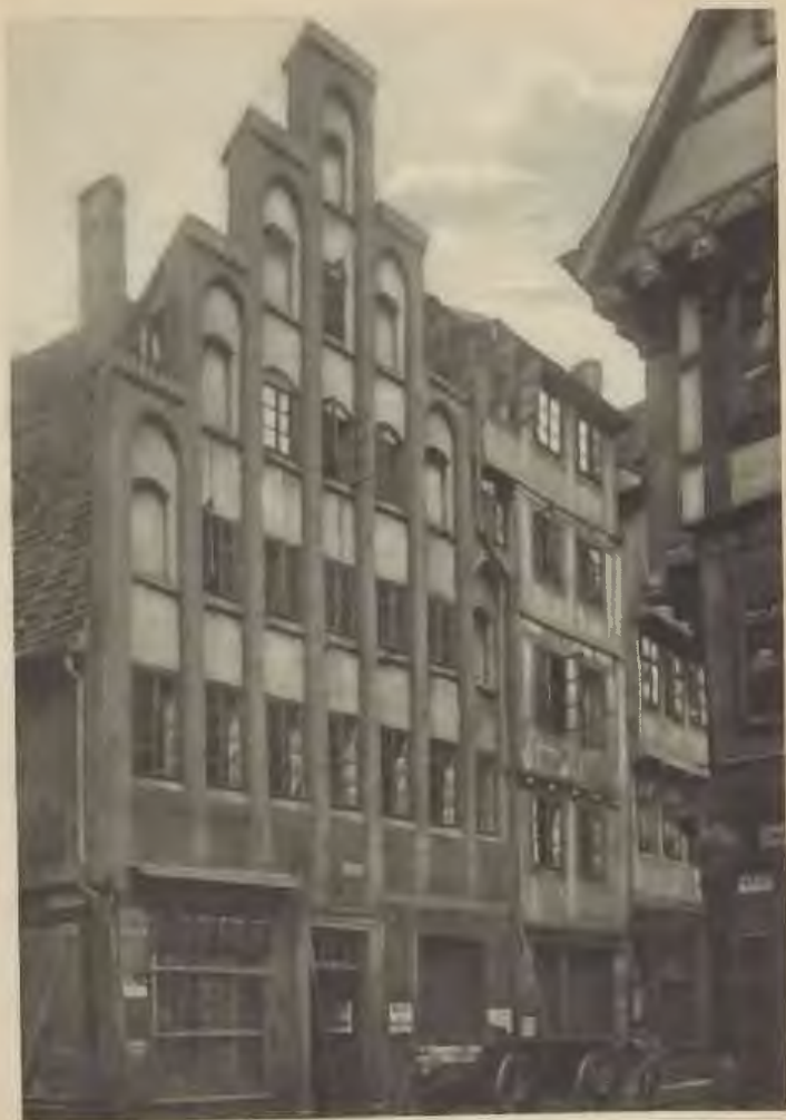
4. Mittelalterlicher Backsteinbau, früher Schuh- und Knochen- hauerstraßen-Ecke. Der später angelegte Fachwerkbau drückt auf den Giebel.
