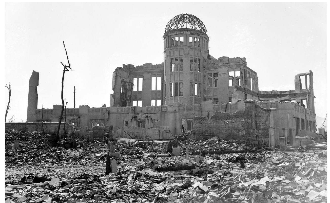
Die Industrieausstellungshalle der Präfektur Hiroshima, heutiges Friedensdenkmal in Hiroshima, nach der Atombombe (Foto: US Strategic Bombing Survey / Quelle: Friedensmuseum Hiroshima)
