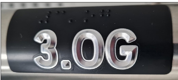
Abbildung 43: Musteransführung eines taktilem kontrastreichen Handlaufschildes (Bildquelle: www.taktile-bodenleitsysteme.de, Allgäu ART Hotel (Kempten))
