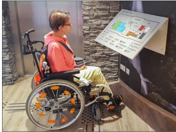
Abbildung 41: Musteransführung eines Übersichtsplans als Tast- und Reliefplan (Bildquelle: www.taktile-bodenleitsysteme.de, Allgäu ART Hotel (Kempten))
